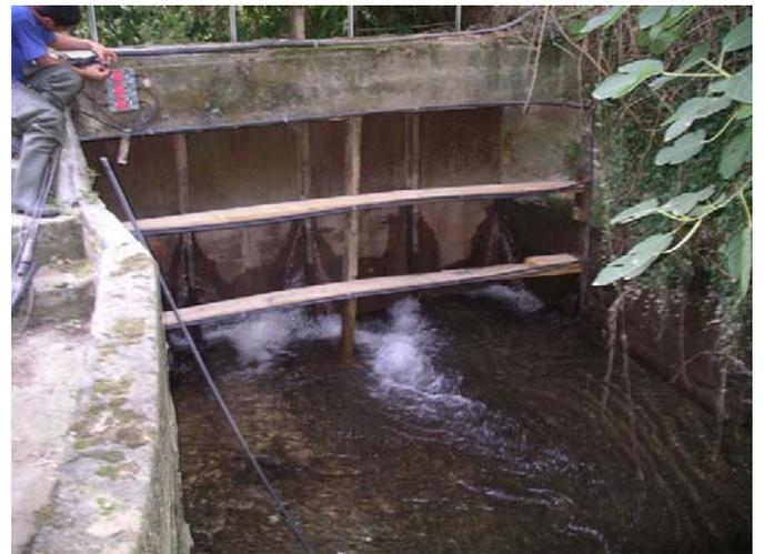
Foto 4. Montaje de Antenas 1, 2 y 3 en toma
