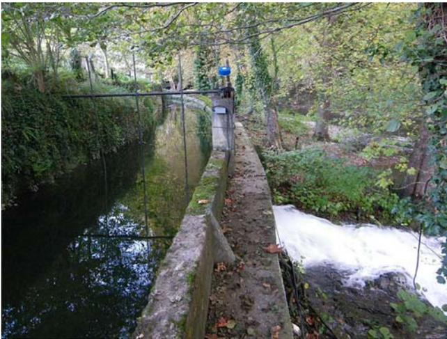
Foto 7. Barrera sónica y bypass expulsando agua
