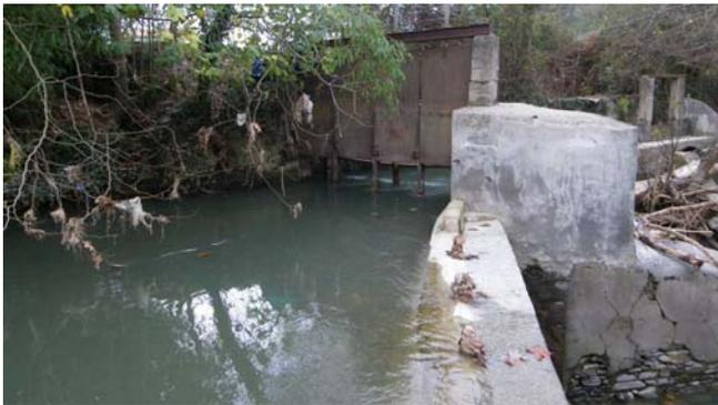
Foto 3. Toma – inicio canal de derivación
